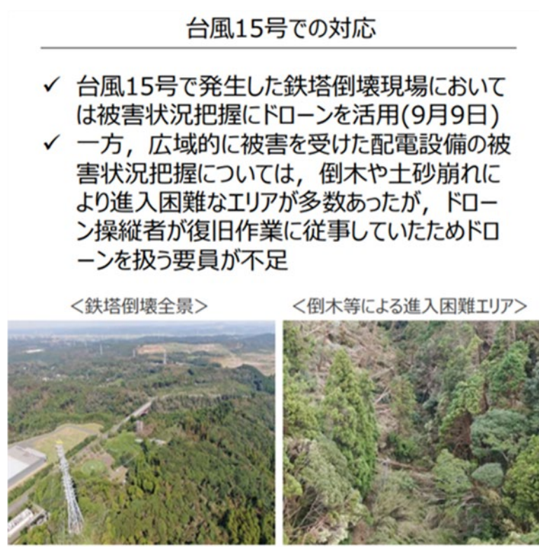
図表 3-98 令和元年房総半島台風におけるドローンの活用
