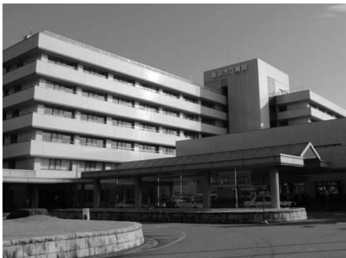
飯田市立病院の外観
