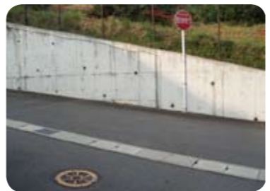
地下に埋設された防火水槽の例
