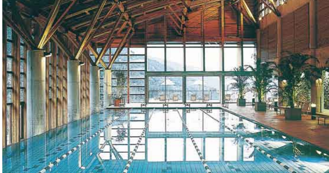
平成10年に完成した、地熱を利用したヒートポンプ方式を採用している「雲の上のプール」。地熱で230kW相当のエネルギーを供給しており、約7割の電力コスト削減を実現した。
