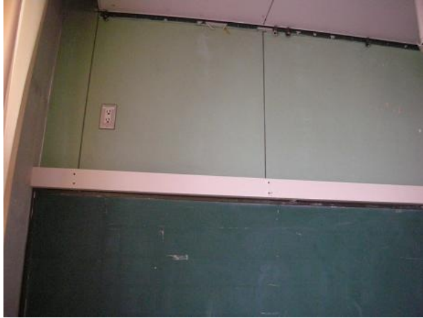
黒板の上下に補強材を設置
