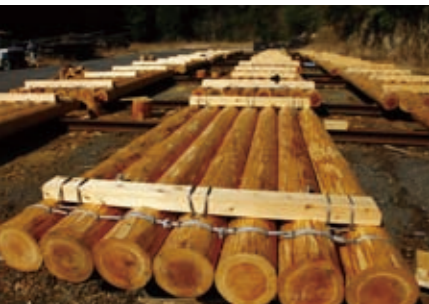
杉の丸太で組んだ筏を縦に7艘連ね、一床全長30メートルが完成。クレーンでの上げ下ろしと組立に6時間かかる。
