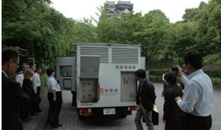
移動電源車を見学する参加者
