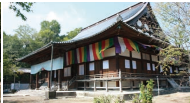
善導寺本堂（重要文化財）
