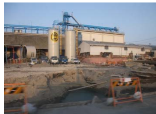
漁港周辺の施設が壊滅的な状況(石巻港)
