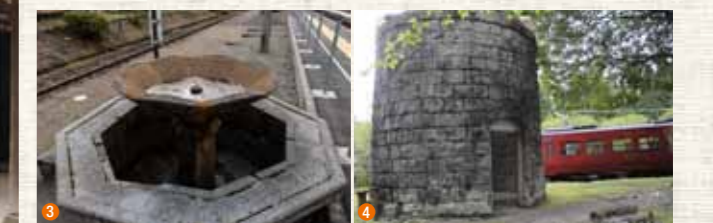
①大畑駅から見えるスイッチバックとループ線 ②大畑駅駅長の池田夫妻と鉄道観光案内人の立山さん。貢献度の高い民間人が名誉駅長に起用される駅もある ③SL機関士たちが顔や手を洗っていた水盤 ④高さ約3mある石造りの給水塔
