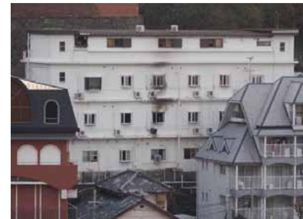
火災建物(中央白の建物)の外観
