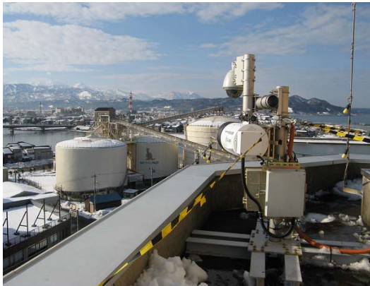
(a) 受信局設置状況
