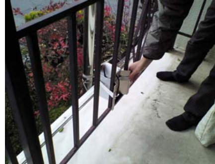
協力者宅ベランダへの設置作業
