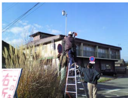
カーブミラーへの設置作業
