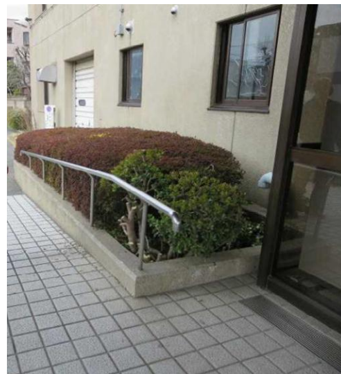
(改善後) 手すりから突出した植栽を伐採
