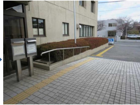
(改善後) 駐輪していた自転車を撤去
