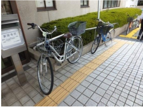
(改善前) 傾斜路の点字ブロック上に自転車が駐輪
