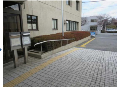
(改善後) 駐輪していた自転車を撤去
