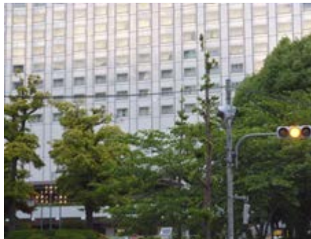
2 国道15号 品川駅北交差点
