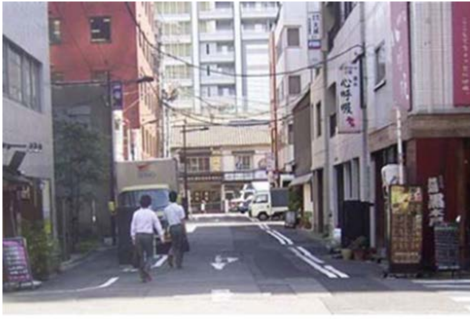
電線類地中化の整備前
