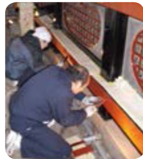
下地から惜しみなく浄法寺漆を使用(二社一寺の修復現場)
