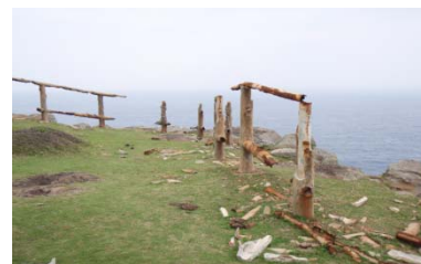
(老朽化した落下防止柵の再整備)
