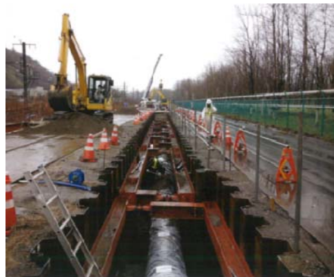
管路の布設工事
