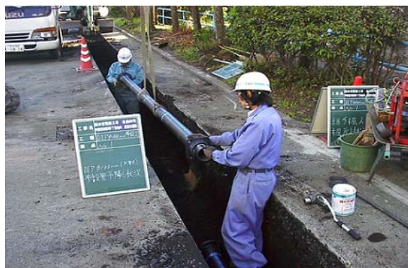
管路の布設工事
