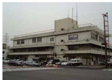
老朽化した警察施設
