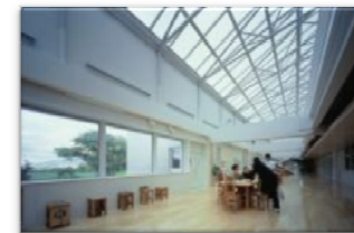
外断熱、自然光利用、自然換気などのエコ改修
