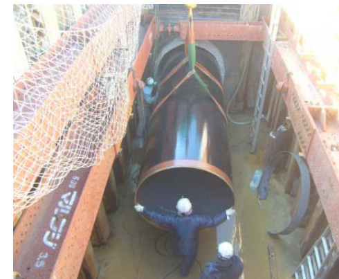
管路の更新工事(老朽管内に新管を挿入)
