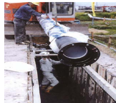
老朽管の更新工事
