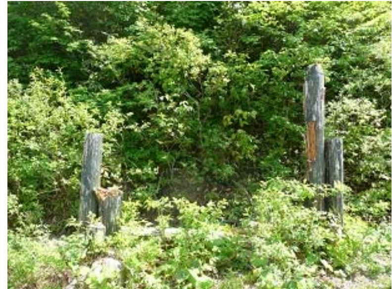
⑩ 破損し支柱のみ残された標識
