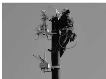
写真5 小型固定無線（18GHz帯FWA）システムのアンテナ
