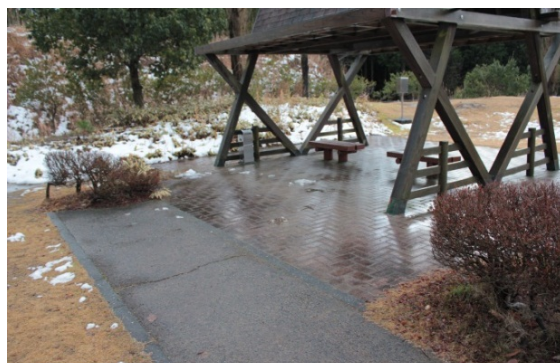
【NO. 10】蒜山高原SA（下り）
