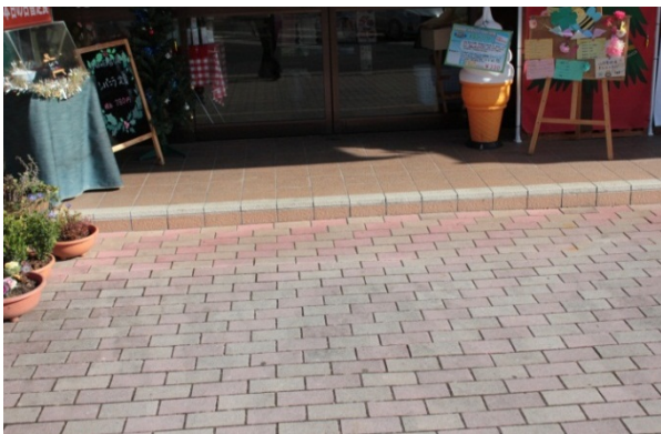
【NO. 1】真庭 P A（下り）
