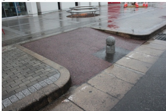
【NO. 17】 小谷S A (上り)
