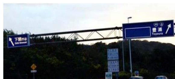
(一般道接続部の標識)
