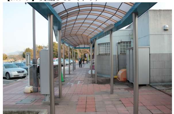
【NO. 6】奥屋 P A (下り)
