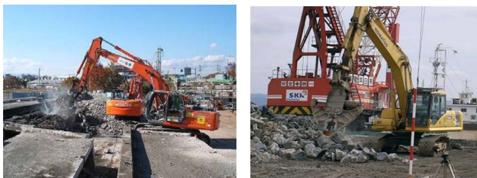
図 5-4 コンクリート圧砕機による桁破碎作業
