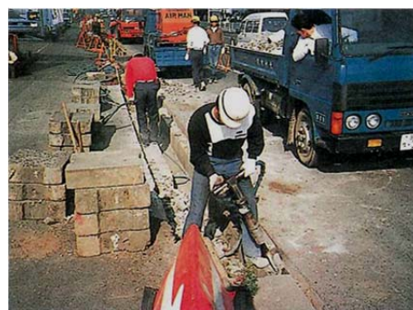
図 5-3 構造物の取り壊し作業
