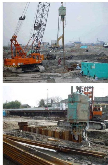
図 5-5 バイブロハンマによる鋼矢板吊り上げと打込み作業
