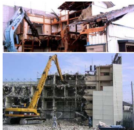
図 5-2 施工状況の全景
