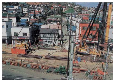
図 5-6 アースオーガ施工状況
