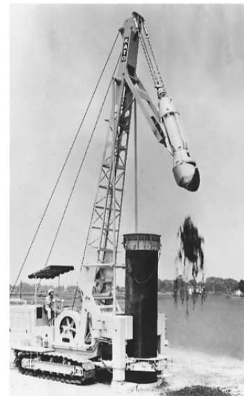
図 13 オールケーシング掘削機
