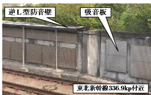
図2.2 逆L型防音壁と吸音板の設置状況
