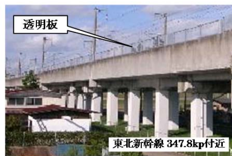
図2.3 嵩上げ防音壁（透明板）の設置状況
