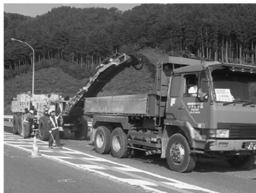
図 24 路面切削機（ダンプ後方の機械）
