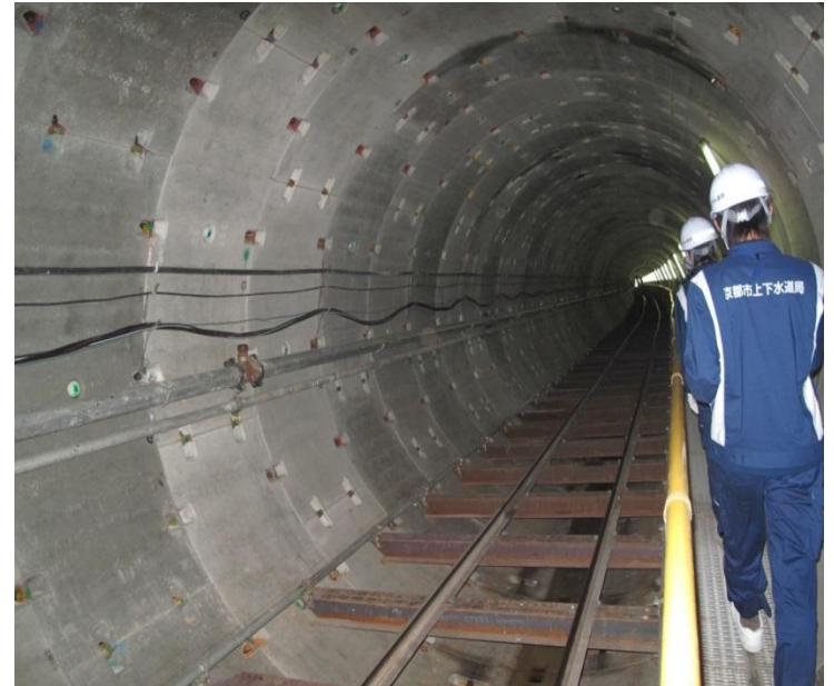
雨水幹線内の様子
