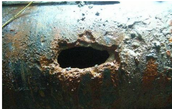
貫通箇所拡大
