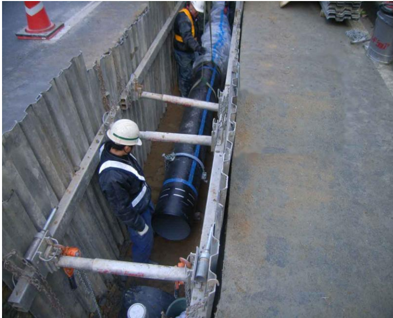
水道配水管の更新作業の様子
