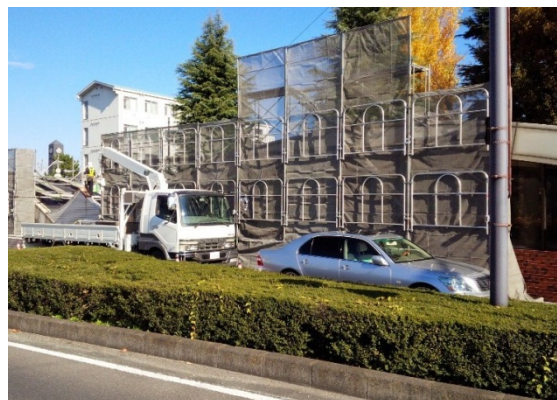
(改修中の現場の様子)
