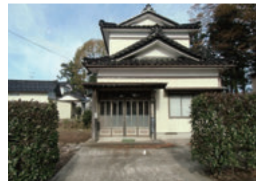
広野の家 希望者に移住を体験してもらうため、空き家を多機能型施設としてリノベーションしました。
