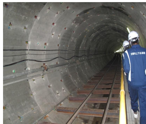
雨水幹線内の様子
