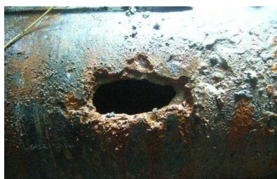
貫通箇所拡大
