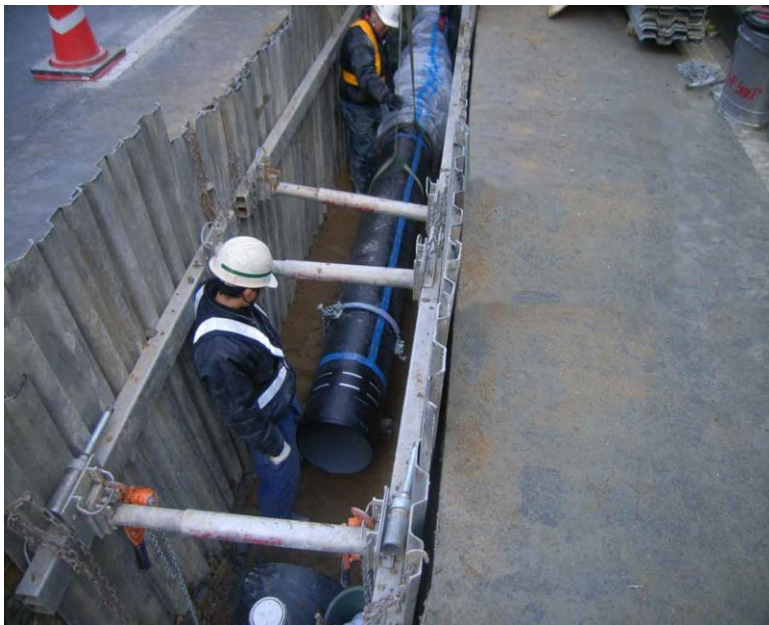
水道配水管の更新作業の様子
