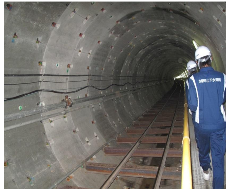
雨水幹線内の様子
