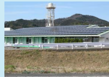
図1（太陽光発電全景）
