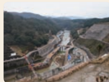
東シナ海へそそぐ川内川の河口から約51kmに位置。九州随一の大きさを誇る重力式ダムです。
