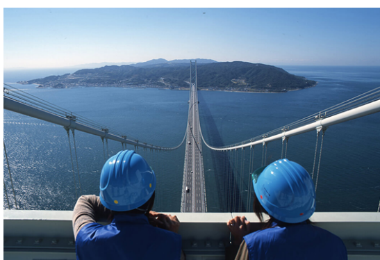
国土交通省総合政策局インフラツーリズム開発 しまなみ海道来島海峡大橋登頂ツアー
