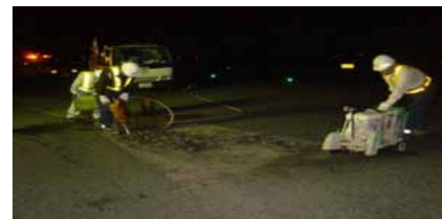
(緊急補修:舗装の破損等により、航空機の運航に支障が生じないように、緊急に補修を実施)
