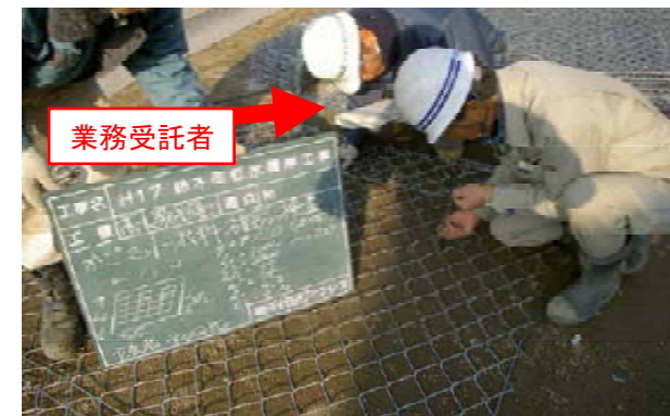
（河川護岸用かごマットの材料確認）
