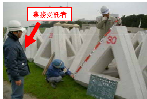
（根固めブロックの材料確認）
