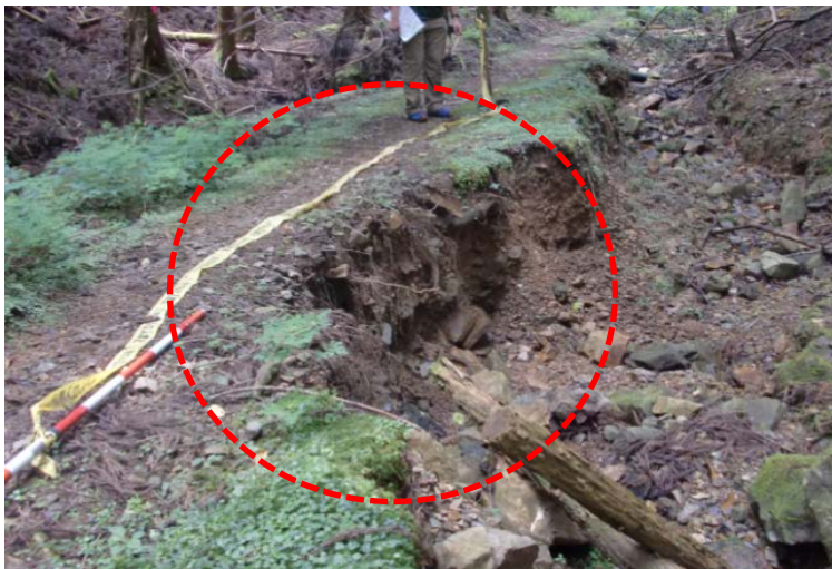
① 遊歩道の崩壊した路肩(明治の森箕面)
