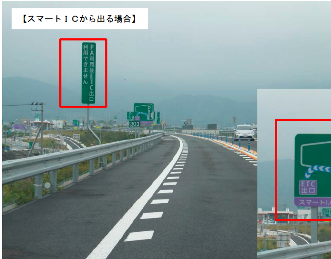
松茂PA手前の本線脇に設置されている注意看板1 (PA利用後ETC出口利用できません)
