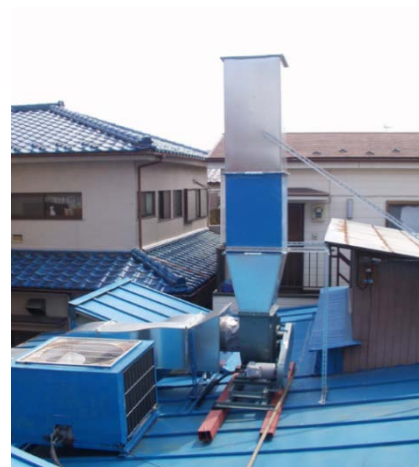
写真4 排出口の高さ、向きの改善の一例
