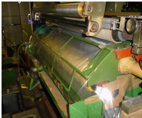
写真3 においが発生する場 所にカバーを付設している例
