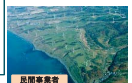
○ユーラス苫前ウインドファーム ・発電所出力 20,000kW ・基数 20基 ○苫前ウインピラ発電所 ・発電所出力 30,600kW ・基数 19基
