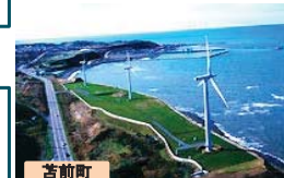
○タ陽ヶ丘ウインドファーム～風来望 ・発電所出力 2,200kW ・基数 3基
