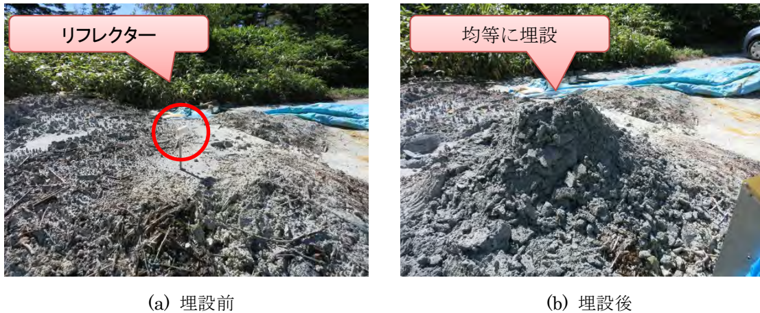
付図 6-16 リフレクターの埋設風景
