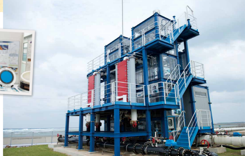
右／100kW規模の発電能力の海洋温度差発電実証施設。左／沖縄県海洋深層水研究所の所長・鹿熊信一郎さん。
