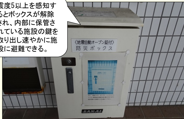
【地震自動解錠鍵BOXを設置している例】
