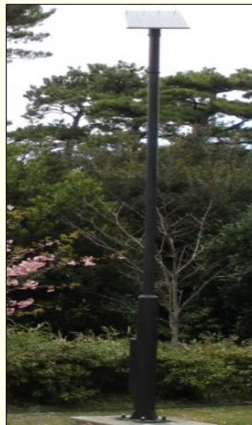
【ソーラー電源(左)とこれを利用した照明器具を設置している例】 (静岡県沼津市)
