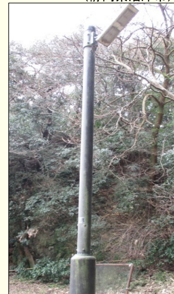
【ソーラー電源(左)とこれを利用した照明器具を設置している例】 (静岡県沼津市)
