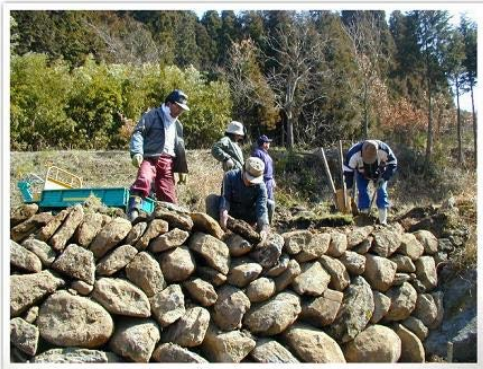
棚田を作り上げる石垣積み教室
