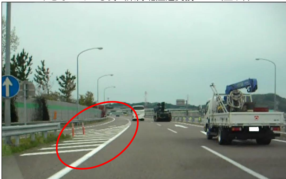
図表 13 ラバーポールがゼブラゾーン起点から 2 本設置されているのみとなっている例（東海北陸道美濃 I C（上り））
