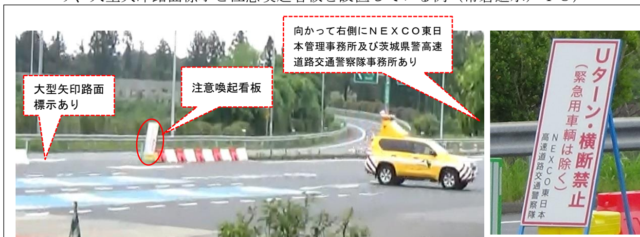
図表16 道路管理者や警察の車両等が横断するために料金所プラザ内の一部を開放しており、大型矢印路面標示と注意喚起看板を設置している例(常磐道水戸IC)
