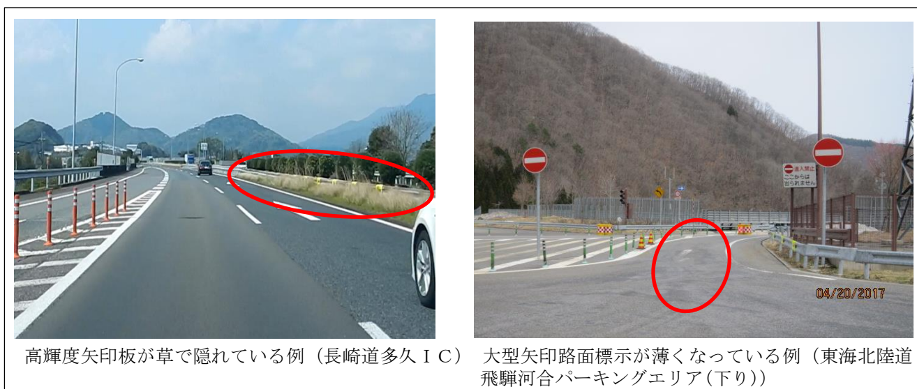
図表 14 老朽化や樹木で隠れているなどにより視認しづらい例
