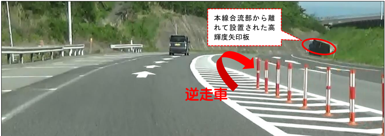
図表 10 高輝度矢印板が本線合流部から離れて設置されている例（中央道岡谷 JCT）
