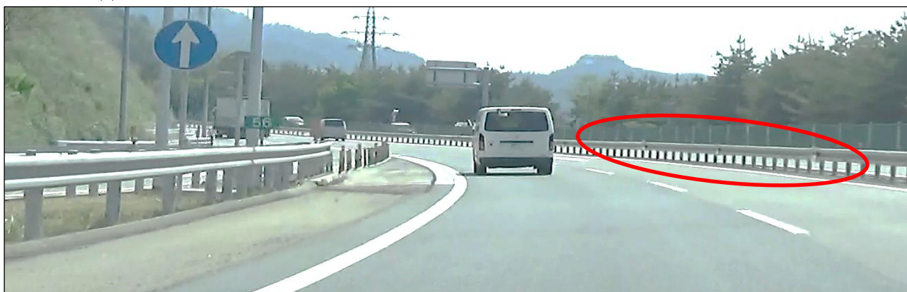
図表 12 高輝度矢印板がゼブラゾーンの間中部から設置されている例（長野道麻績 I C（上り））
