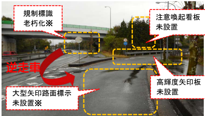
対策工事の対象として位置付けられていない高速道路出口部 (舞鶴若狭道福知山IC)
