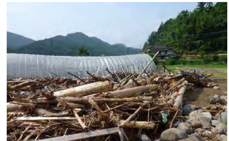
日田市内の被害の様子
