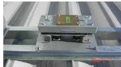
図-18 振動節の固体伝搬音低減 注釈 1. 動吸振器の設置により建屋壁、屋根から放射されていた低周波音を低減した。 注釈 2. 動吸振器は橋梁の振動低減などにも応用されている。
