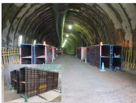
図-4 音響管を利用したトンネル発破時の低周波音低減（主に 16~20 Hz 帯域の発破音を吸音、低減） 6)
