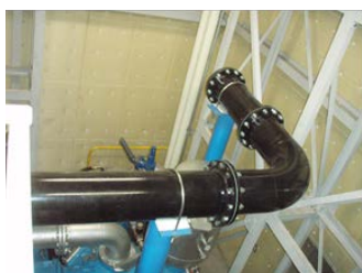
室内空間に必要な長さのブランチ管を配置
