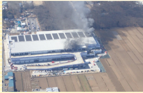
火災時の建物の状況（2月16日12時頃） （埼玉県防災航空隊提供）
