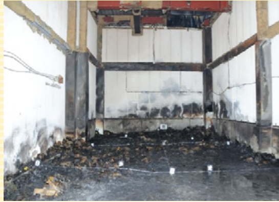
1階端材室内部の状態
