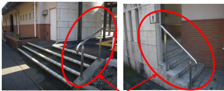
階段に手すりを設置
