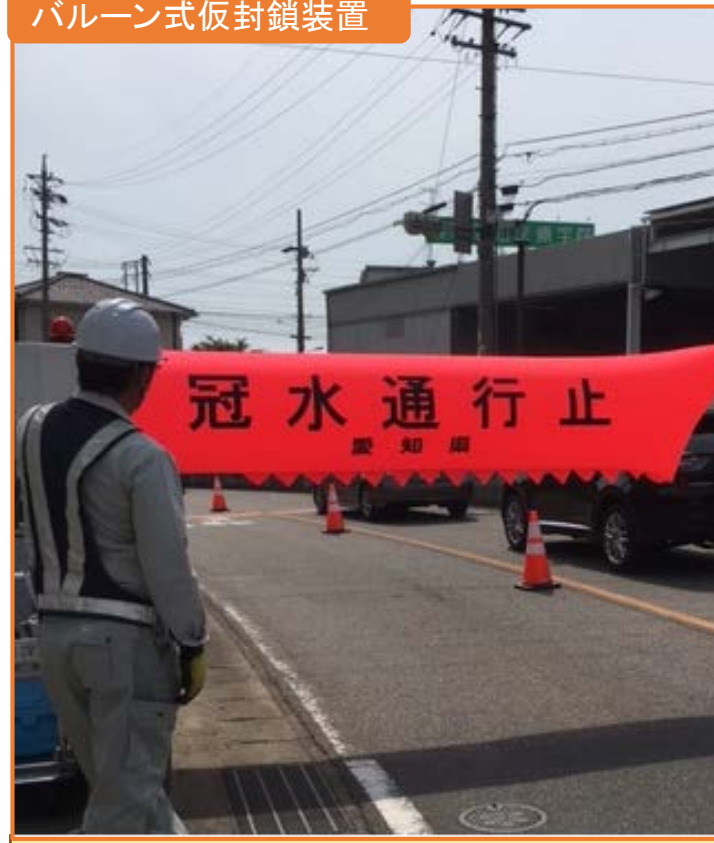
バルーン式仮封鎖装置
