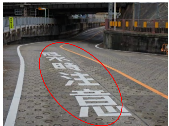
路面表示 (南)「冠水時注意」
