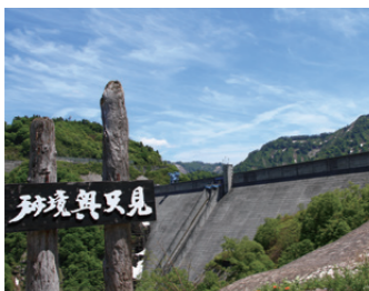
魚沼市には奥只見ダムをはじめ、破間川ダム、黒又ダムなど8つのダムがあり、スタンプラリーも行われている。
